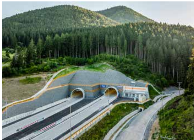
Obr. 2 Východní portál tunelu s portálovou budovou
