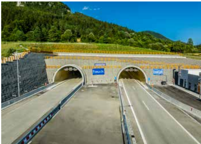
Obr. 1 Západní portál tunelu Čebrať
