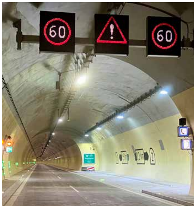
Obr. 4 Nouzový záliv v dokončeném tunelu
