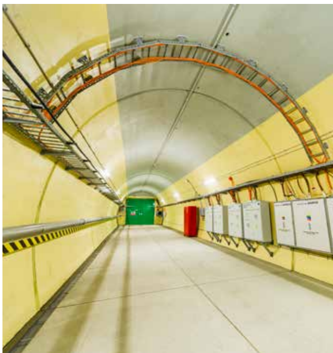
Obr. 3 Tunelová průřezná propojka
