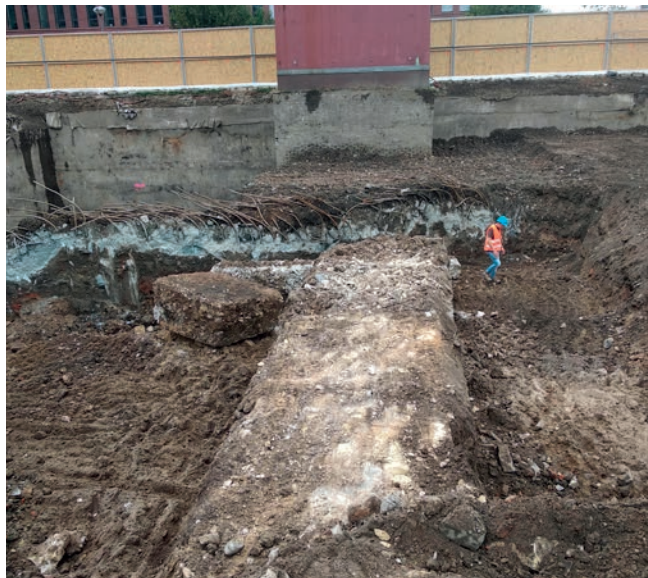
Skryté betonové a železobetonové konstrukce
