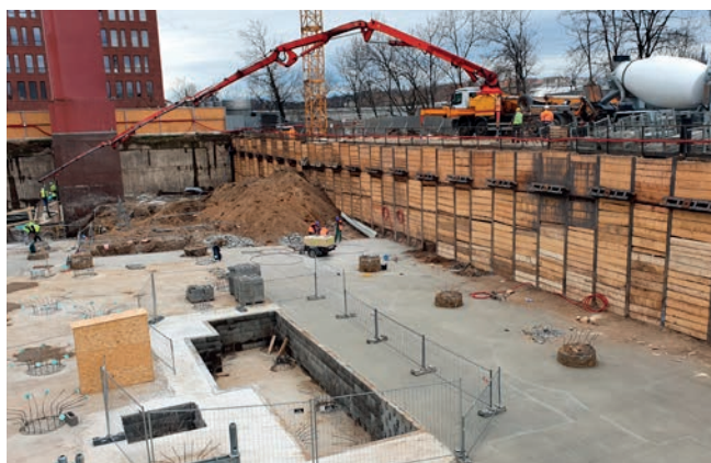
Betonáž pilíře nad metrem
