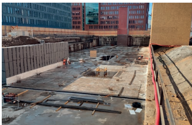
Dokončené dílo s podkladní vrstvou betonu
