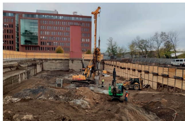
Zemní práce, vrtání pilot, mikropilotáž u šachty metra
